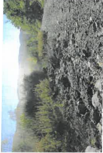
Photo 16 : Prise de vue n°1 : Erosion le long de la piste d'accès ouest de la plateforme sud Les eaux de ruissellements en cas de débordement de la zone de rétention au niveau de la buse D500 ont causé une érosion sur le bord du chemin d'accès
