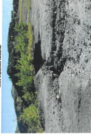
Photo 20 :Prise de vue n°5 : Un des légers entaillements pluviométriques sur la plateforme nord Une partie des eaux de ruissellement se concentrent en un point du talus, entraînant une érosion de ce dernier. L'érosion est cependant limitée par le faible impluvium concerné.
