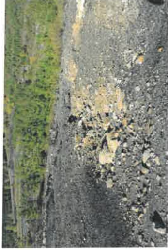
Photo 20 :Prise de vue n°5 : Un des légers entaillements pluviométriques sur la plateforme nord Une partie des eaux de ruissellement se concentrent en un point du talus, entraînant une érosion de ce dernier. L'érosion est cependant limitée par le faible impluvium concerné.
